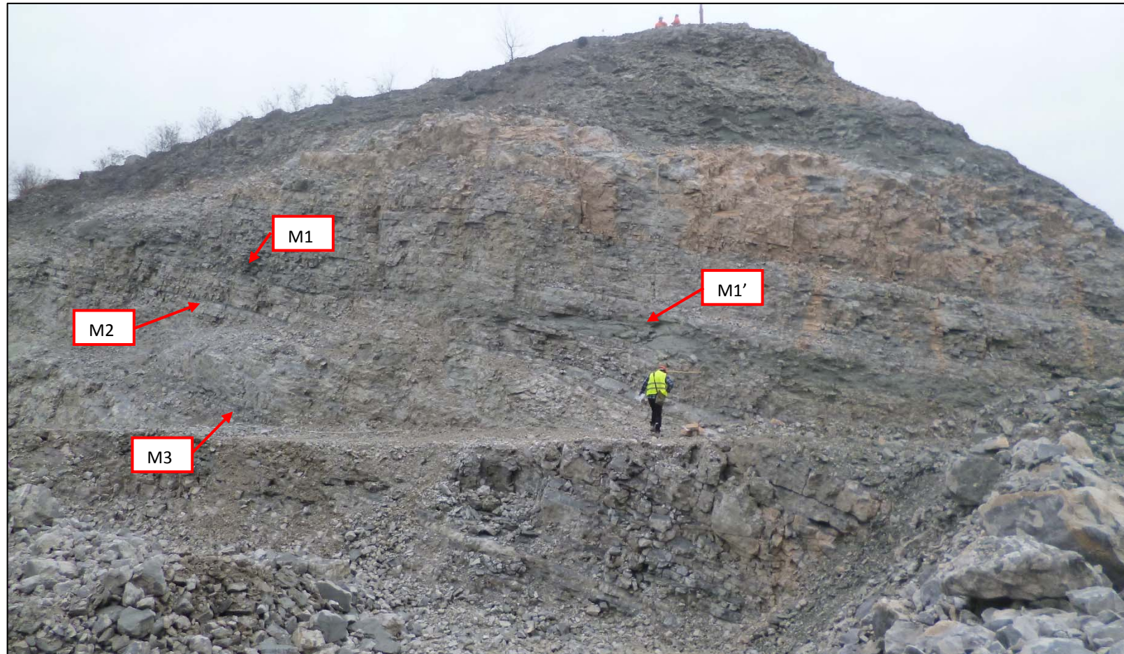
Figura 4.4 – Fronte NO, livelli marnoso argillosi paralleli alla stratificazione (ripresa dicembre 2014)..
