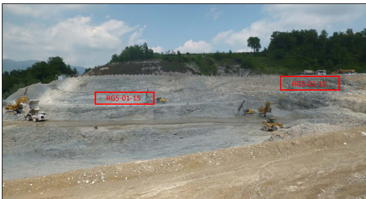
Figura 4.3 – Fronti ONO e OSO, in rosso è indicata la posizione delle aree di rilievo geostrutturale (ripresa giugno 2015).
