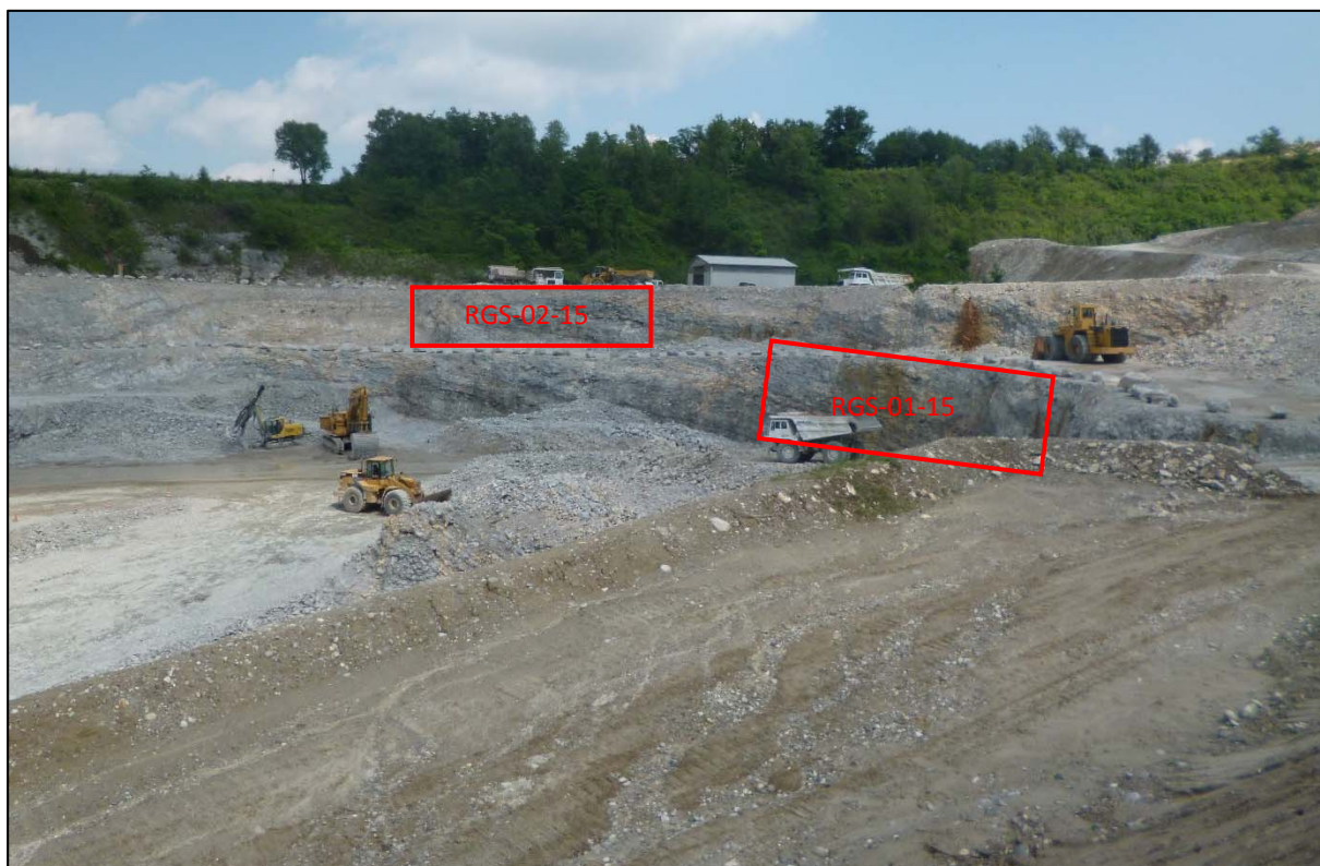
Figura 4.2 – Fronti NO e ONO, in rosso è indicata la posizione delle aree di rilievo geostrutturale (ripresa giugno 2015).
