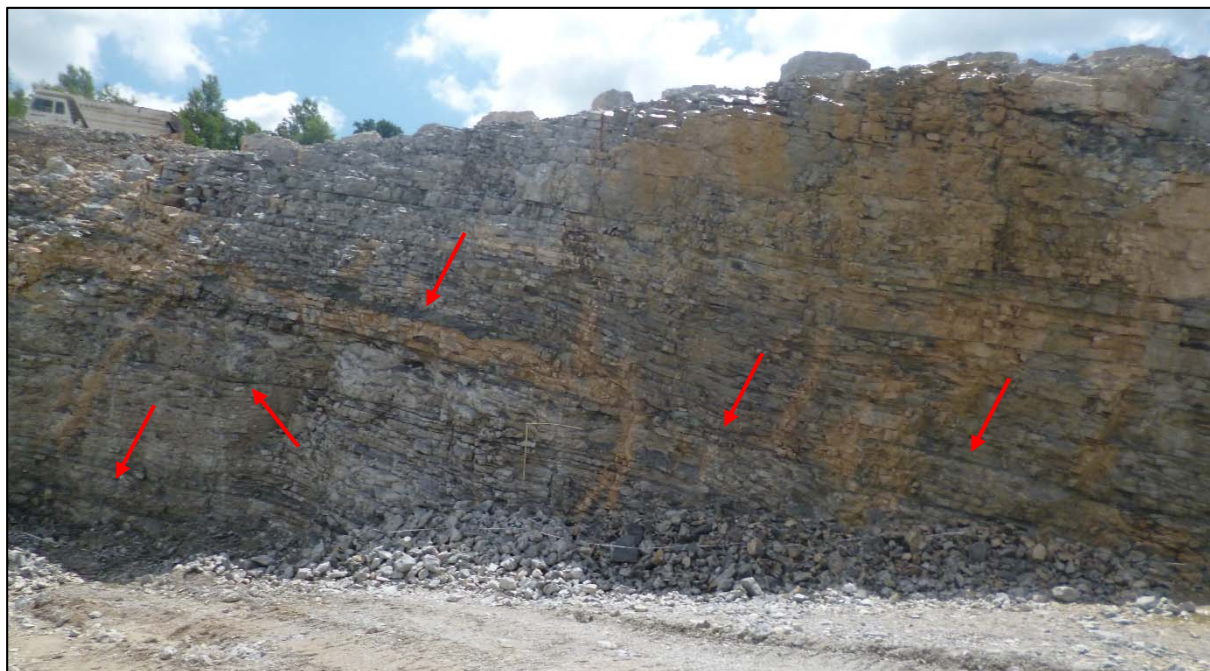
Figura 4.4 – Fronte NO, livelli marnoso argillosi disposti lungo la stratificazione (ripresa giugno 2015)..
